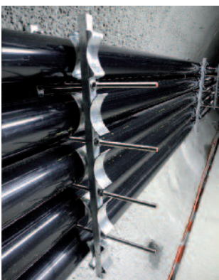
Montage der ersten Lage à 5 Rohre Montage de la première rangée à 5 tubes Montaggio del primo strato di 5 tubi
