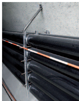
Noflam 10er-Rohrpaket fertig montiert Paquet de 10 tubes Noflam terminés montés Pacco da 10 tubi a montaggio finito
