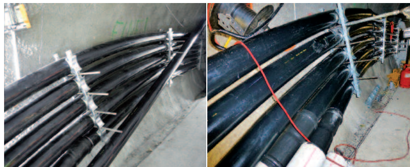
Noflam-Spezialbogen mit verschiedenen Radien Coudes spéciaux Noflam avec différents rayons Tubi speciali Noflam di diverso raggio
